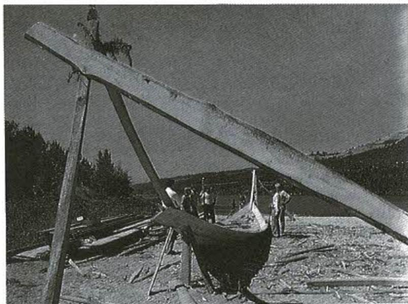
**3.6.** — Seguia-se a estruturação com as *cavernas*. Começava-se pela marcação do seu espaçamento no fundo, o que era feito a partir do comprimento duma pipa (1,50 m). As pipas assentavam — sobre as cavernas, e eram colocadas longitudinalmente, tampo contra tampo. Daí que o espaço entre 2 cavernas sucessivas correspondia sensivelmente a 1/2 pipa.
