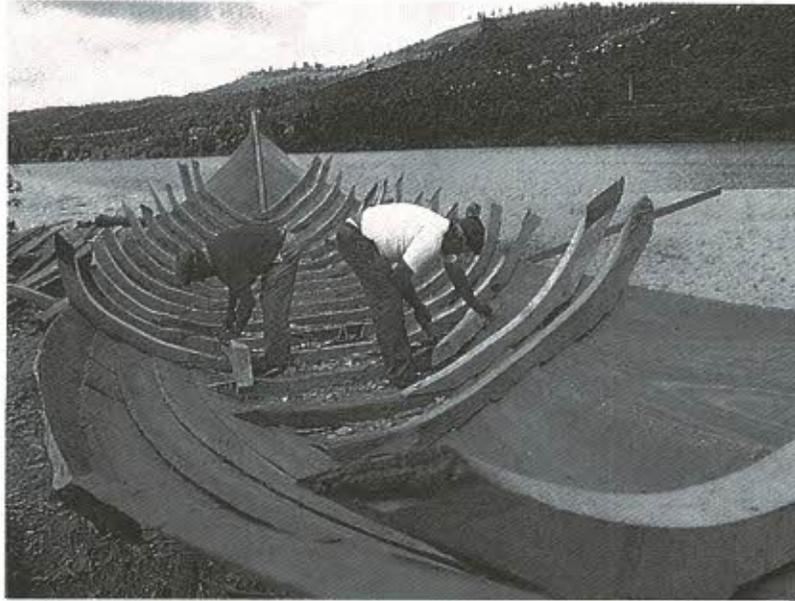
3.7. — Só depois desses reforços transversais se colocavam os reforços das bordas, ao longo destas. Sendo estes barcos de boca aberta, aí necessitavam de peças de reforço muito fortes. Incluíam os *verdugos* + *curvatões* pelo lado exterior, as *dragas* interiormente; e, por cima daqueles, as *chãs*.
