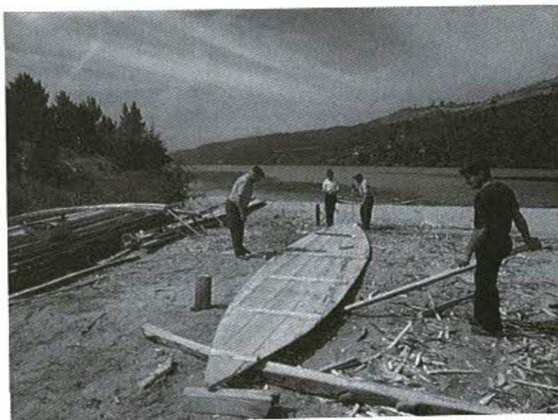
Este fundo de prato tinha uma forma lenticular alongada, assim obtida: o seu eixo longitudinal era dividido em 4 partes iguais, definindo
